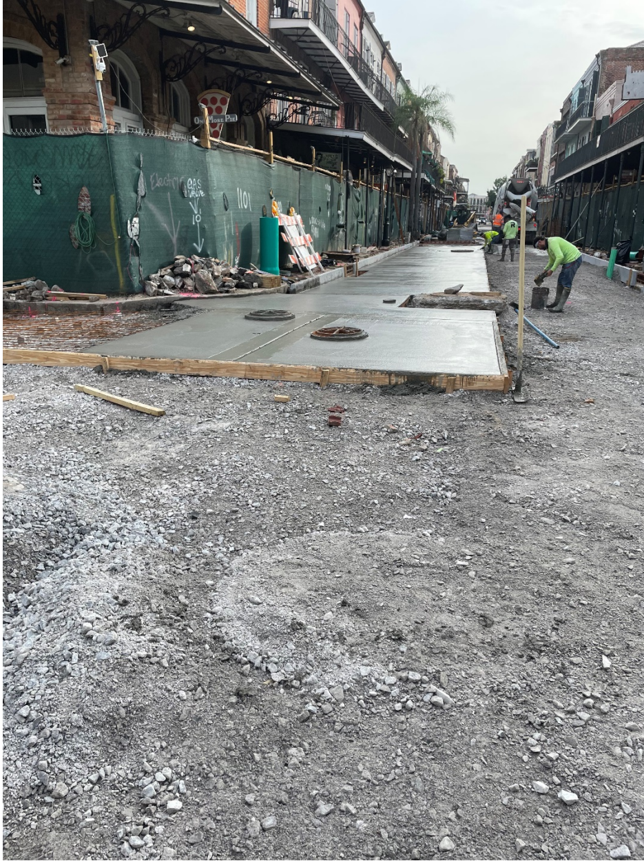
Concrete pour at Ursulines & Decatur
