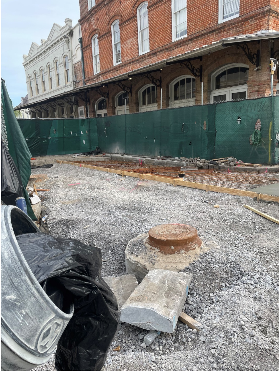
Concrete pour at Ursulines & Decatur
